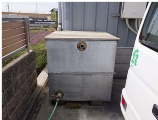
貯留タンクの設置
