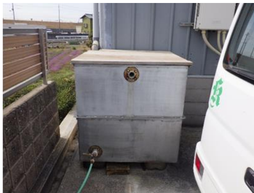
貯留タンクの設置
