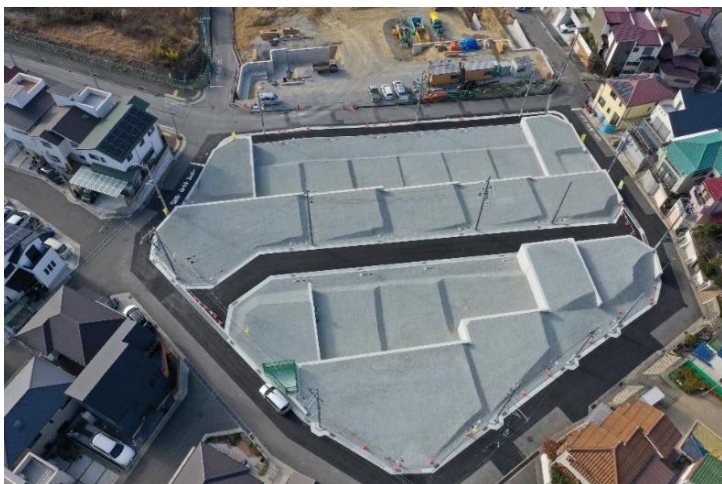
ドローンによる現場出来高の写真撮影
